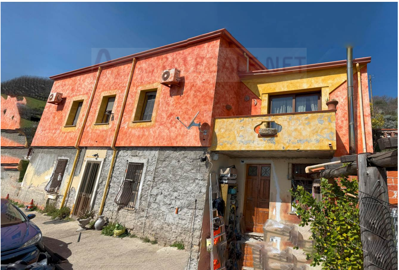
→ Foto 4, vista esterna immobile, dalla corte della corte di pertinenza
