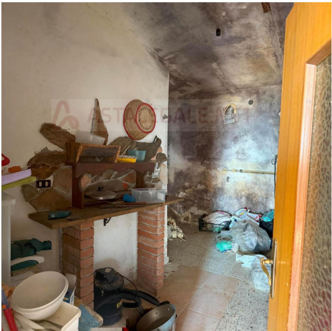
Foto 4, piano terra – vista interna ripostiglio
