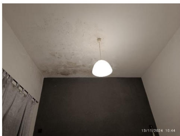
FOTO 18: Macchie di umidità discendente nelle camere 6 e 4 dovute a guasti nell'impermeabilizzazione di copertura
