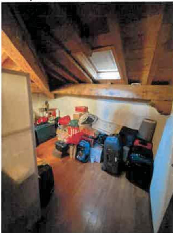
FOTO 30 (vista interna piano secondo su sottotetto – LOTTO 4)
