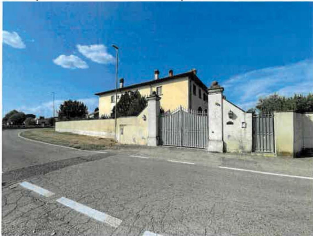
FOTO 1 (vista esterna da via di Giramonte)
