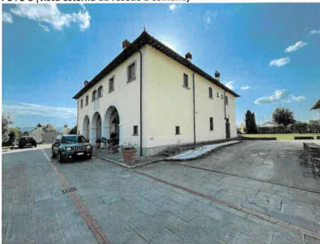
FOTO 3 (vista esterna da resede a comune)
