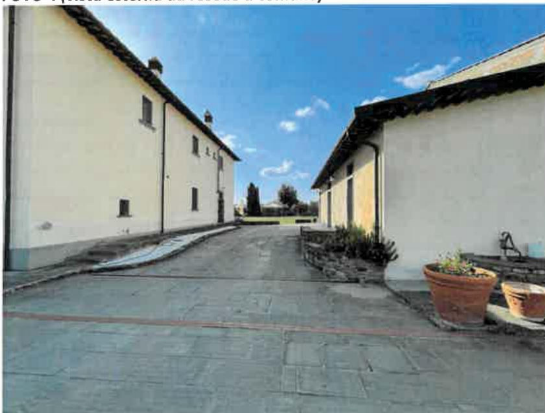
FOTO 4 (vista esterna da resede a comune)
