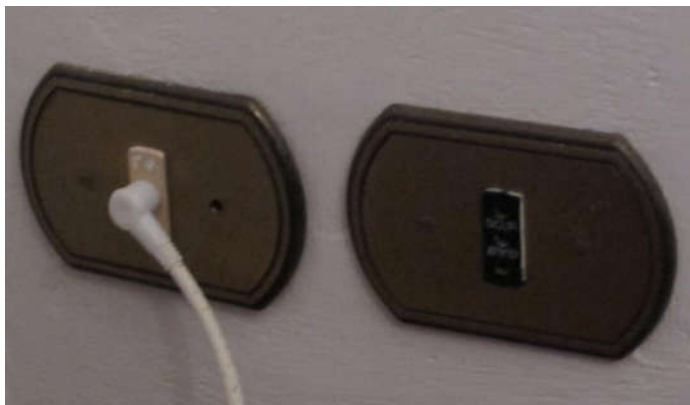
Fig. 4 e 5 – Prese antenna tv terrestre
