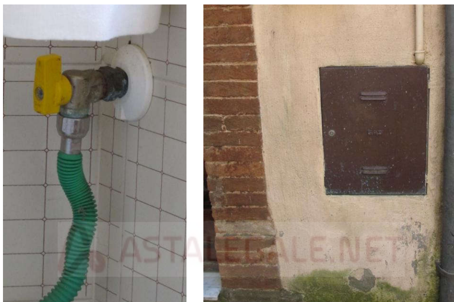
Fig. 20 e 21 – Rubinetto d'intercettazione gpl e collocazione contatore
