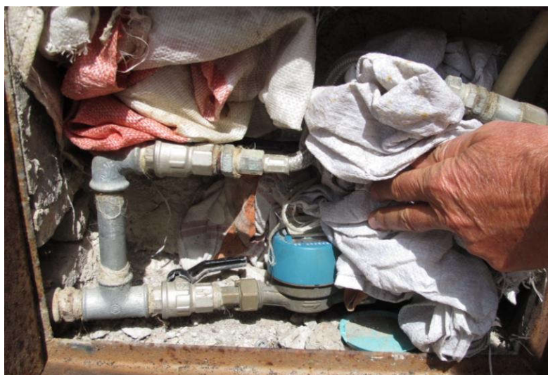
Fig. 15 – Contatore acquedotto
