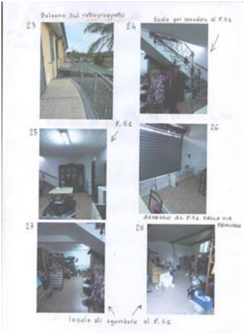
Balcone sul retroprospetto e vista degli interni al P.S1
