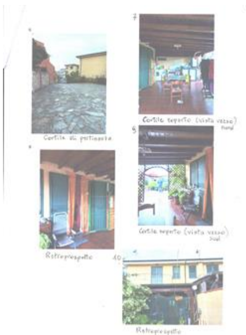
vista della porzione di cortile, sul retroprospetto, coperta con struttura in legno
