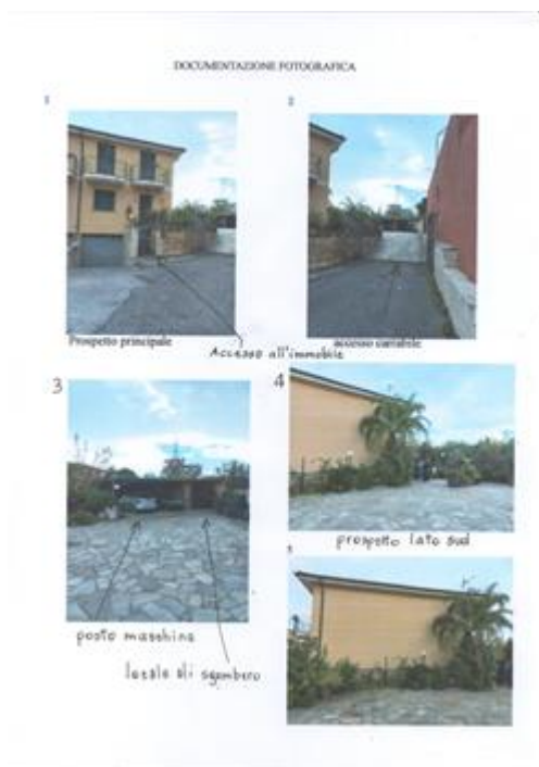
vista dei prospetti e dell'area esterna di pertinenza
