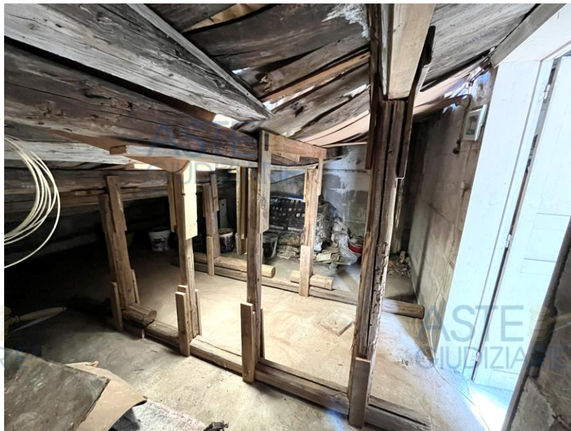
Fig. 7 – Messa in sicurezza tetto copertura locale sgombero.
