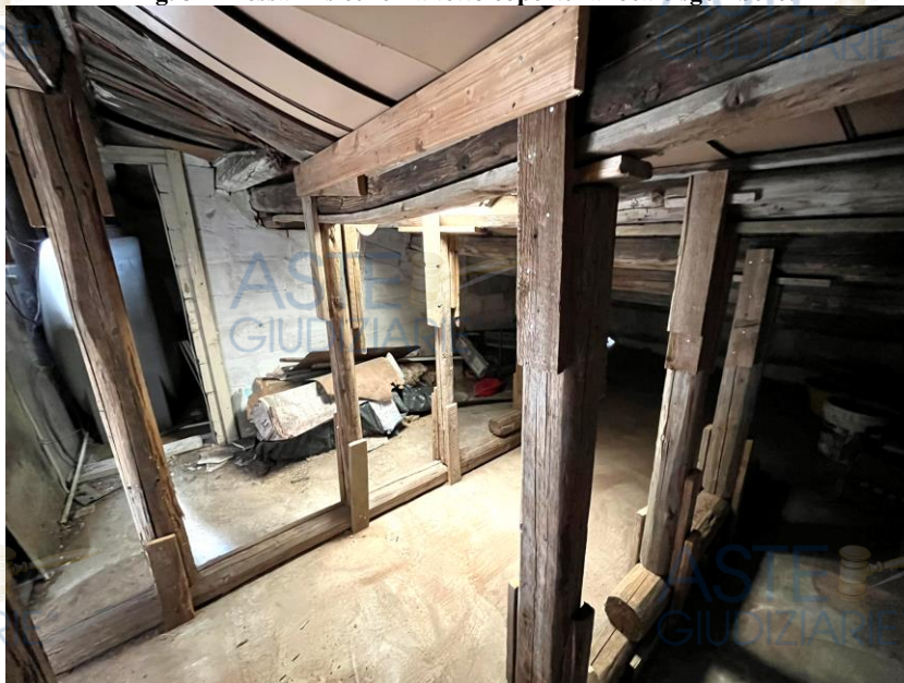
Fig. 6 – Messa in sicurezza tetto copertura locale sgombero.
