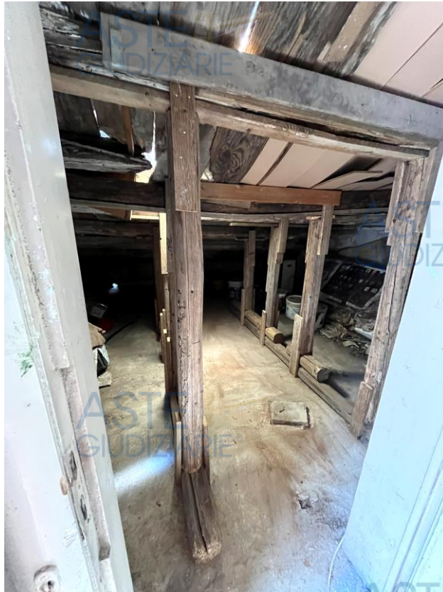
Fig. 5 – Messa in sicurezza tetto copertura locale sgombero.
