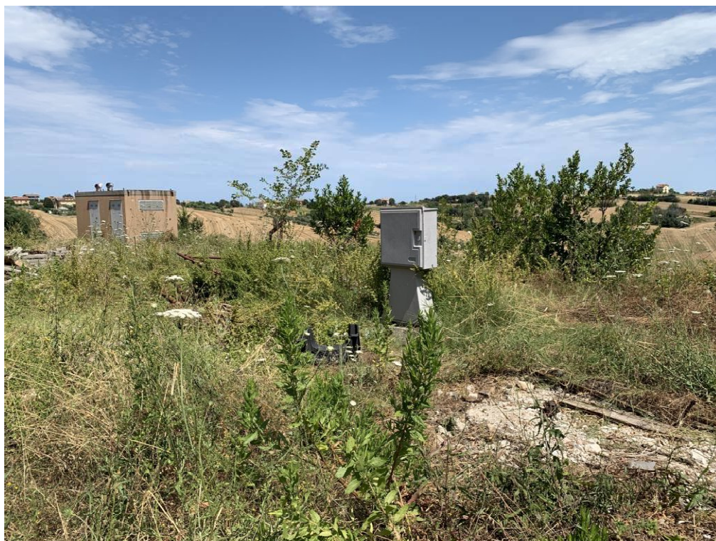
FOTO N.7_vista di qualche opera di urbanizzazione primaria/secondaria realizzata.
