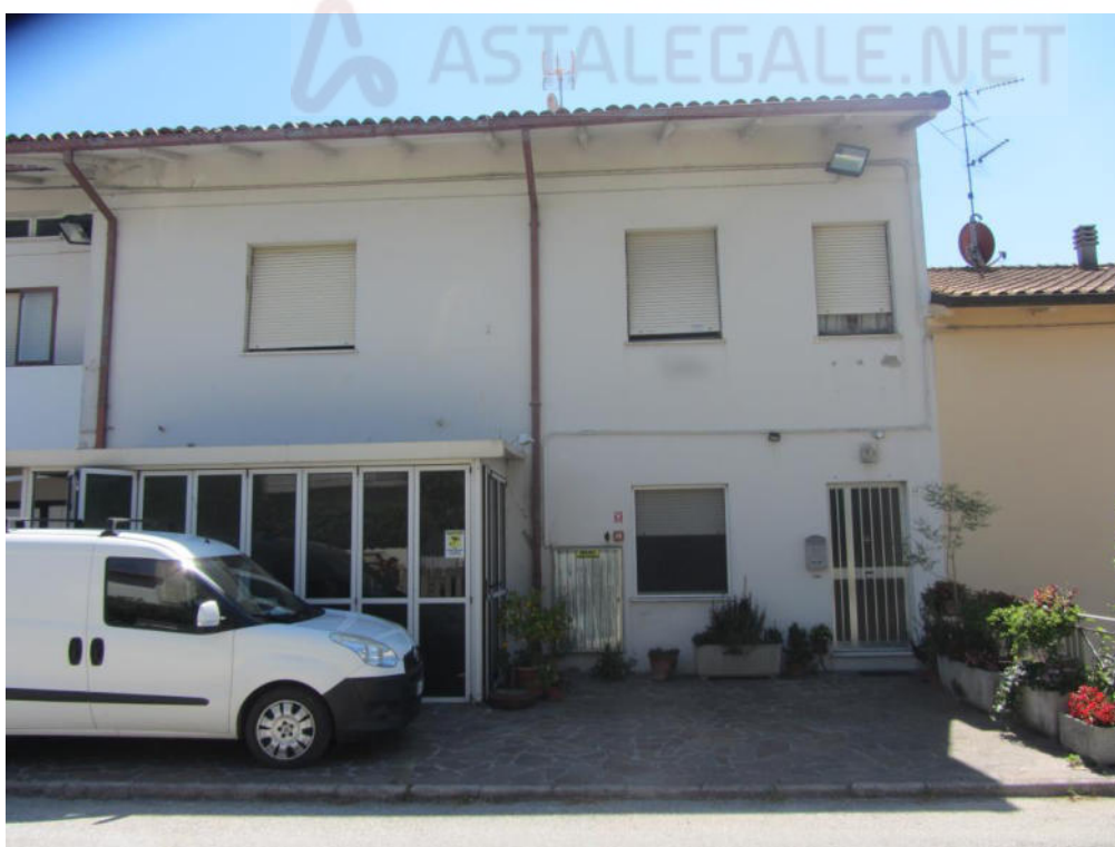
FOTO E.02_ ESTERNO
