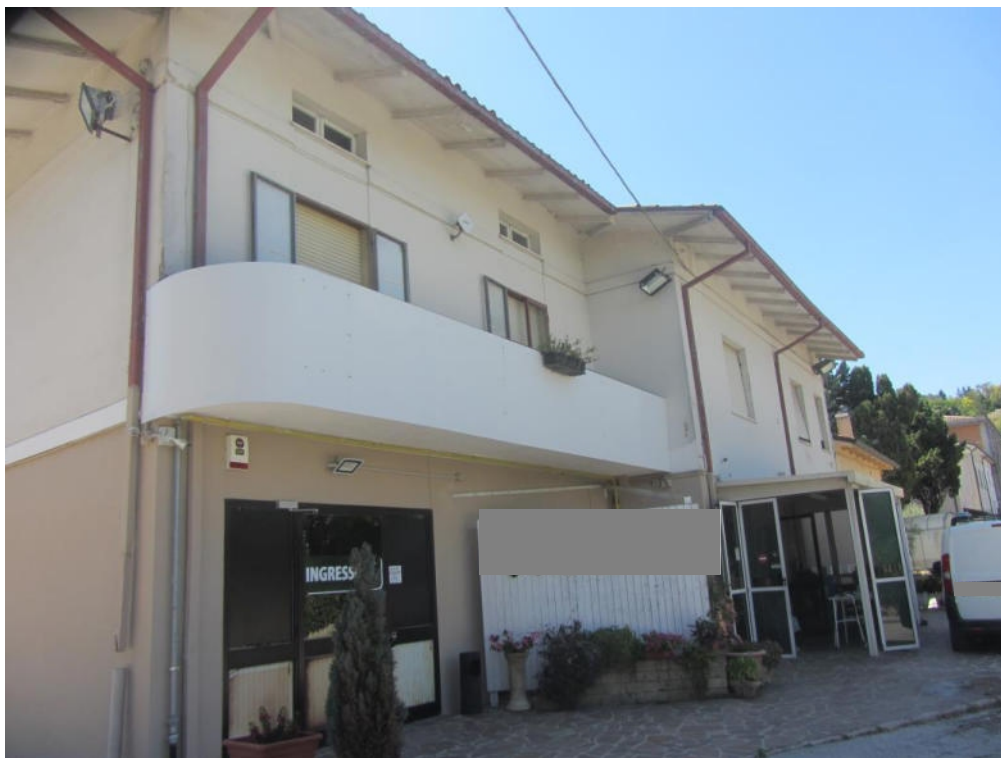
FOTO E.01_ ESTERNO
