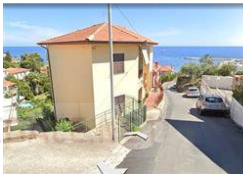
FOTO PANORAMICA DEL FABBRICATO
