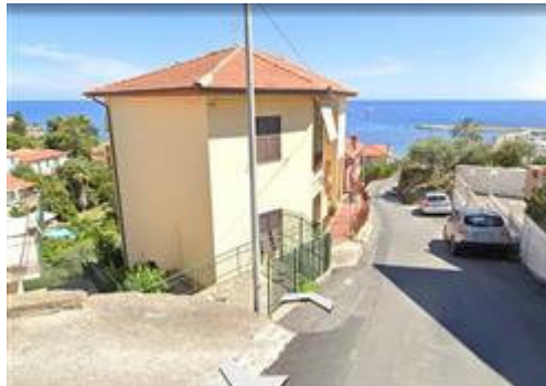
FOTO PANORAMICA DEL FABBRICATO
