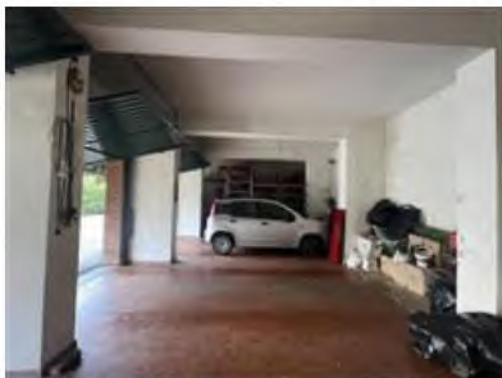
vista dell'interno dell'immobile verso la parete nord
