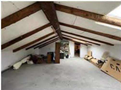
vista del sottotetto
