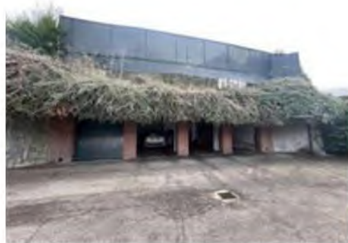
vista esterna dell'immobile
