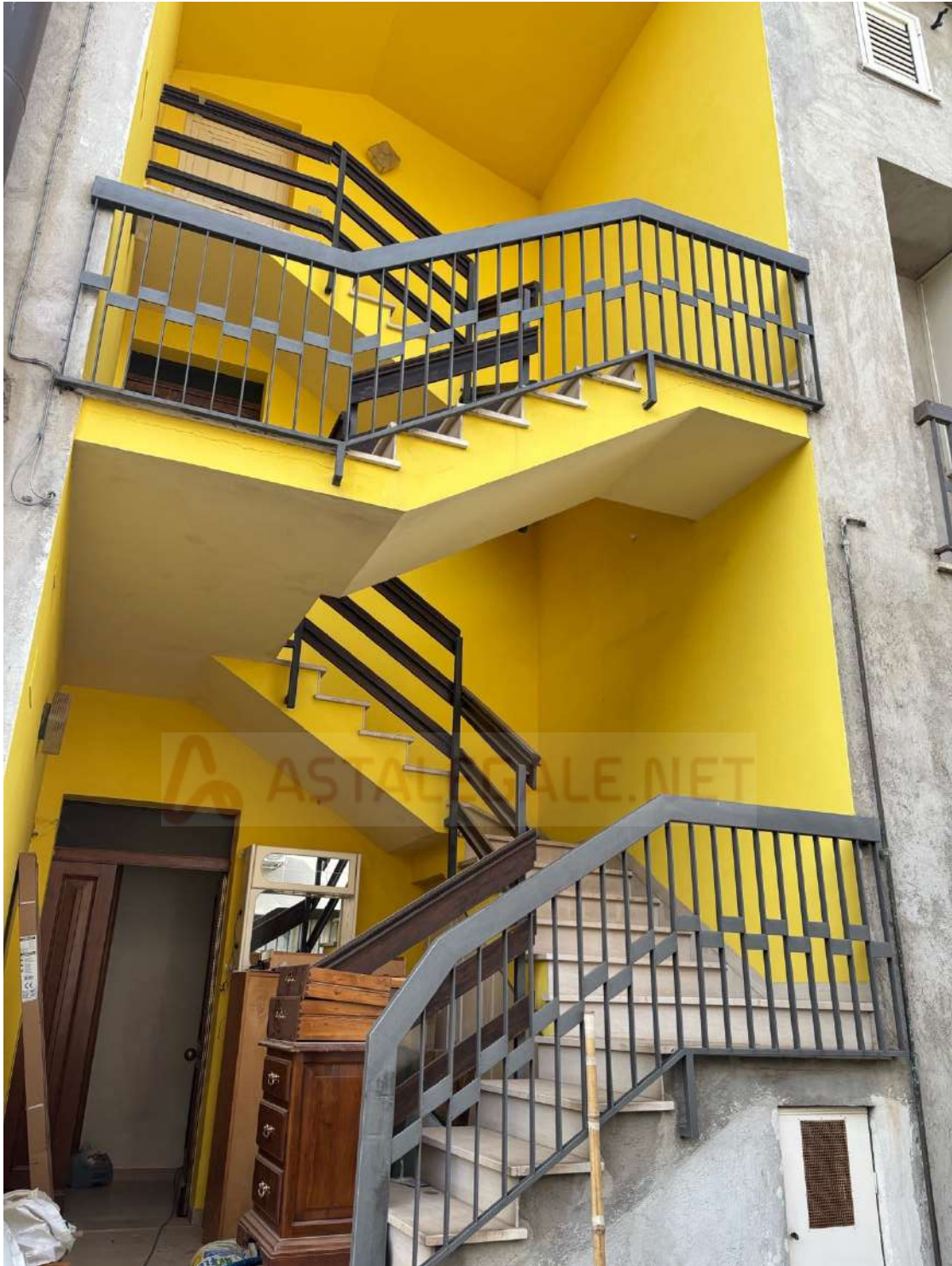
Foto n. 7 – Scala esterna di collegamento ai piani.
