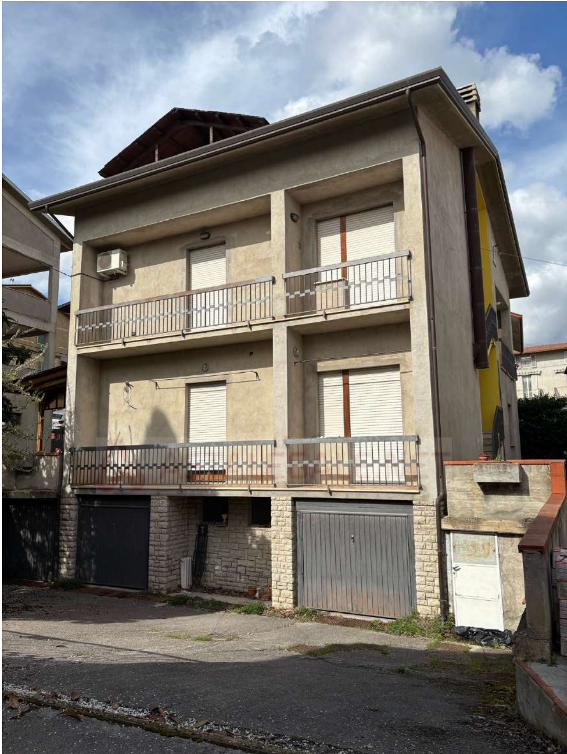
Foto n. 2 – Come foto n. 2.
