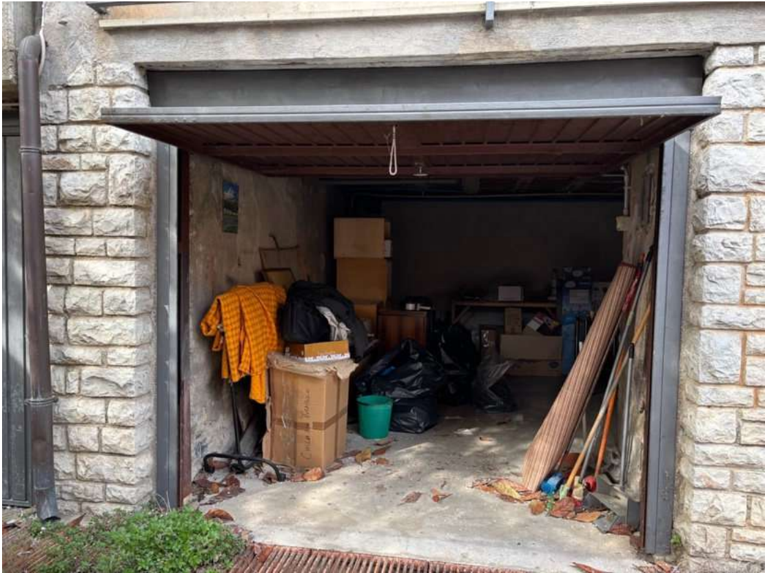
Foto n. 66 – Locale garage (sub. 4).
