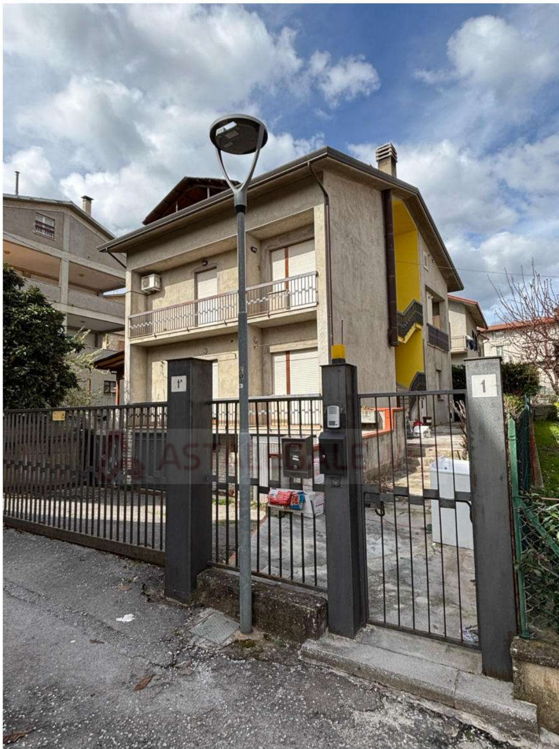
Foto n. 1 – Prospetto frontale: lato sud (Via G. Paisiello).
