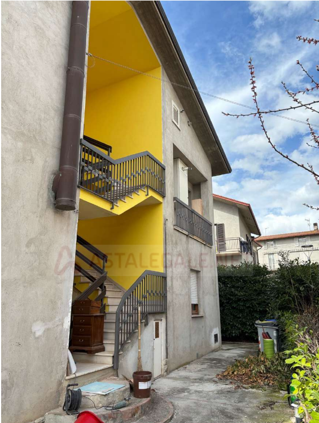
Foto n. 6 – Come foto n. 5.
