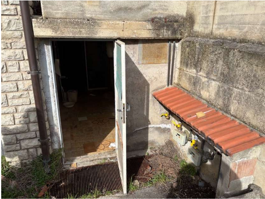
Foto n. 62 – Porta d'ingresso del locale fondo.
