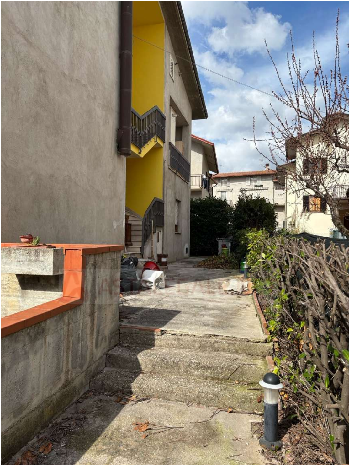
Foto n. 5 – Prospetto laterale (est).
