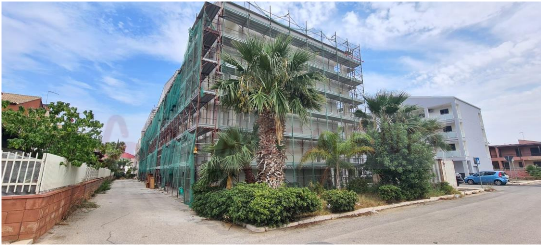
LATO NORD-EST ACCESSO BOX
