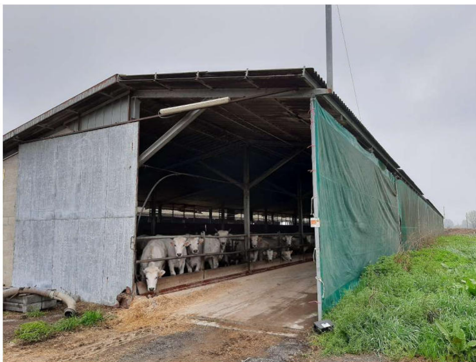
Foto 26 – Subalterno 6 – fabbricato “C”
