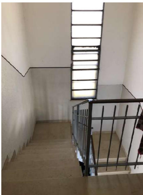
Foto 10 – vano scala sub 2
