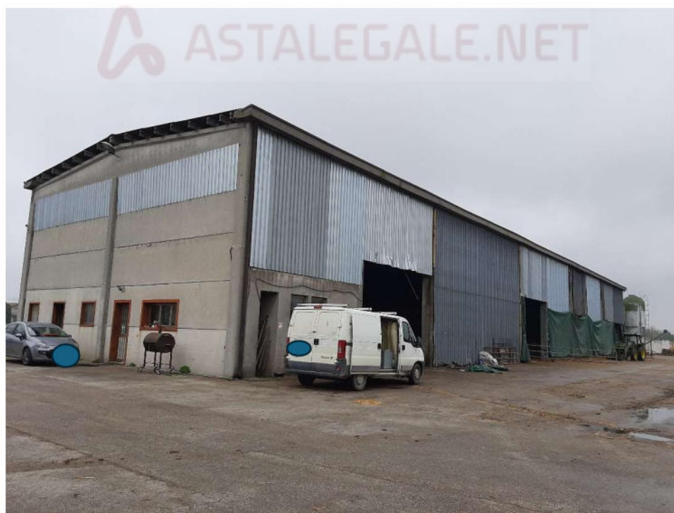
Foto 15 – Sub. 6 fabbricato "A"
