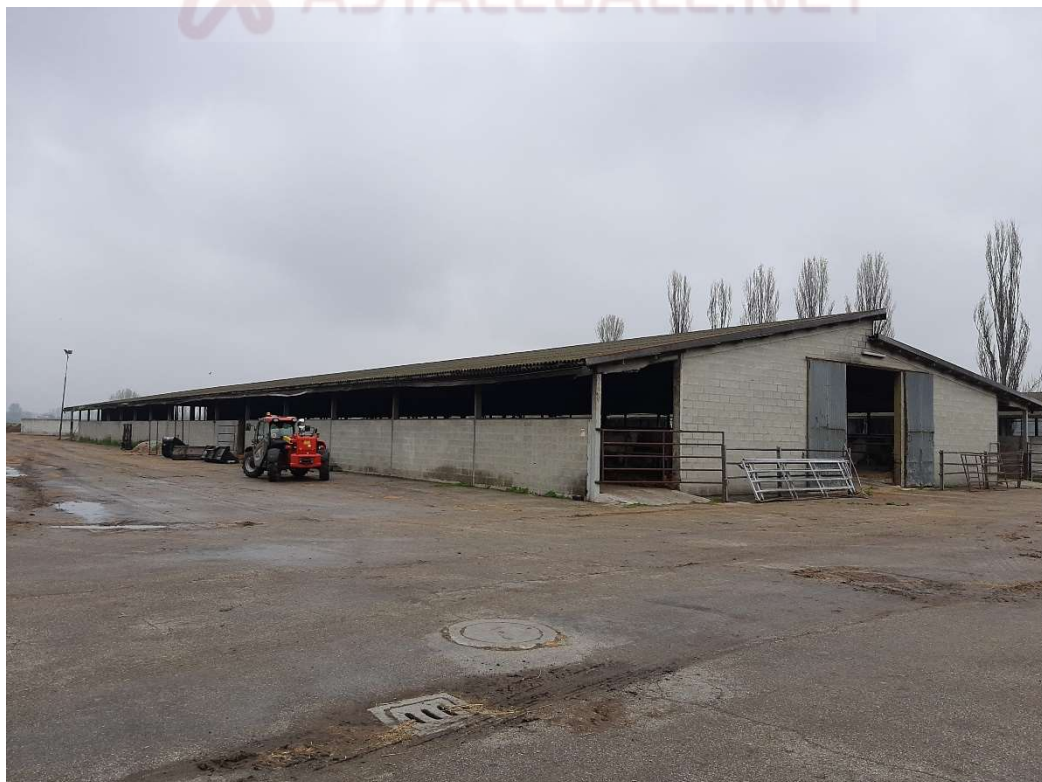
Foto 25 – Subalterno 6 – fabbricato “B”
