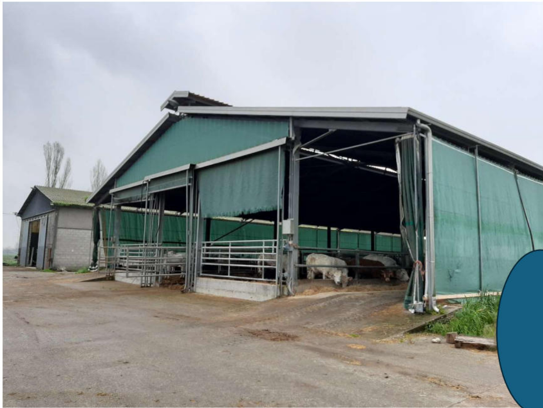
Foto 28 – Subalterno 6 – fabbricato “E”
