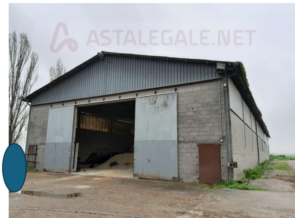
Foto 27 – Subalterno 6 – fabbricato “D”
