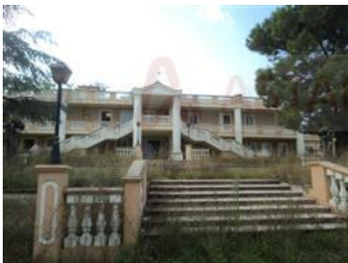
Edificio principale sub 3
