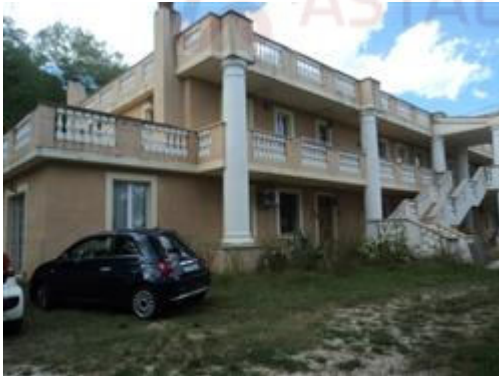
Edificio Principale con scala esterna e ballatoio
