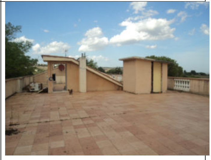
Terrazza di copertura P2 Ascensore e scala
