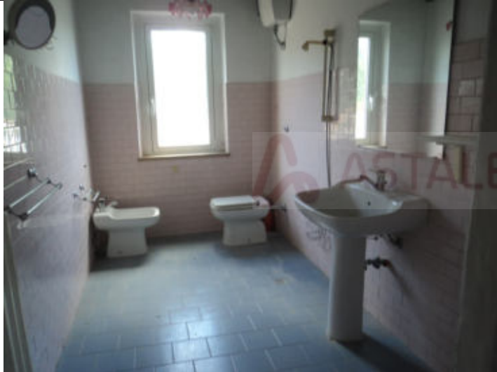
Bagno abitazione n. 6 P2
