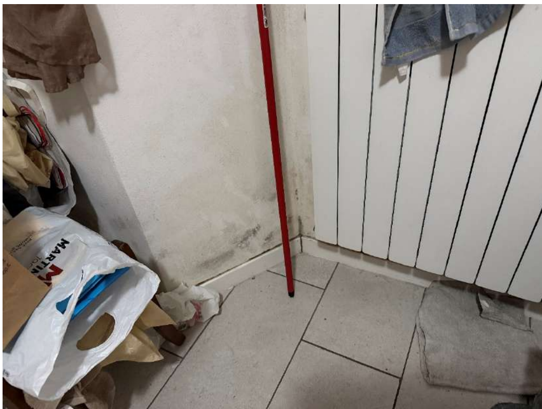
Presenza di umidità/muffa alloggio p.m. 1
