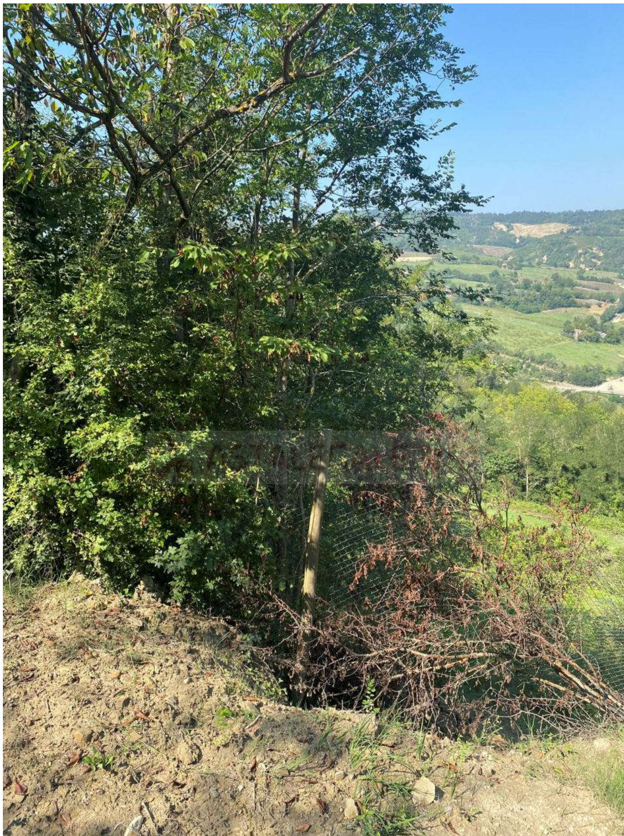
Fot. 22 - Terreni agricoli – Vista delle zone franate in seguito all'alluvione 2023.
