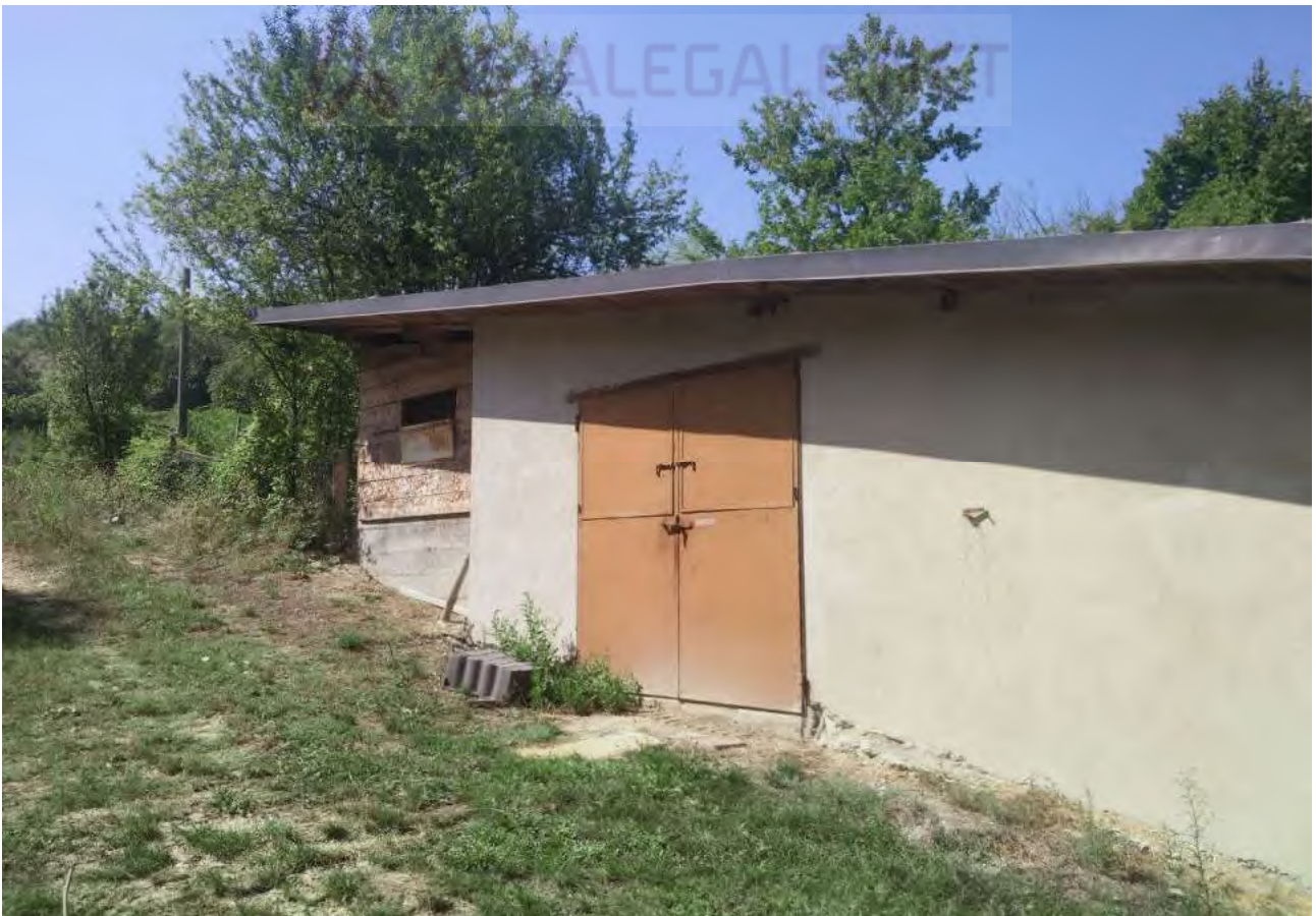
Fot. 3 - Vista del proservizio
