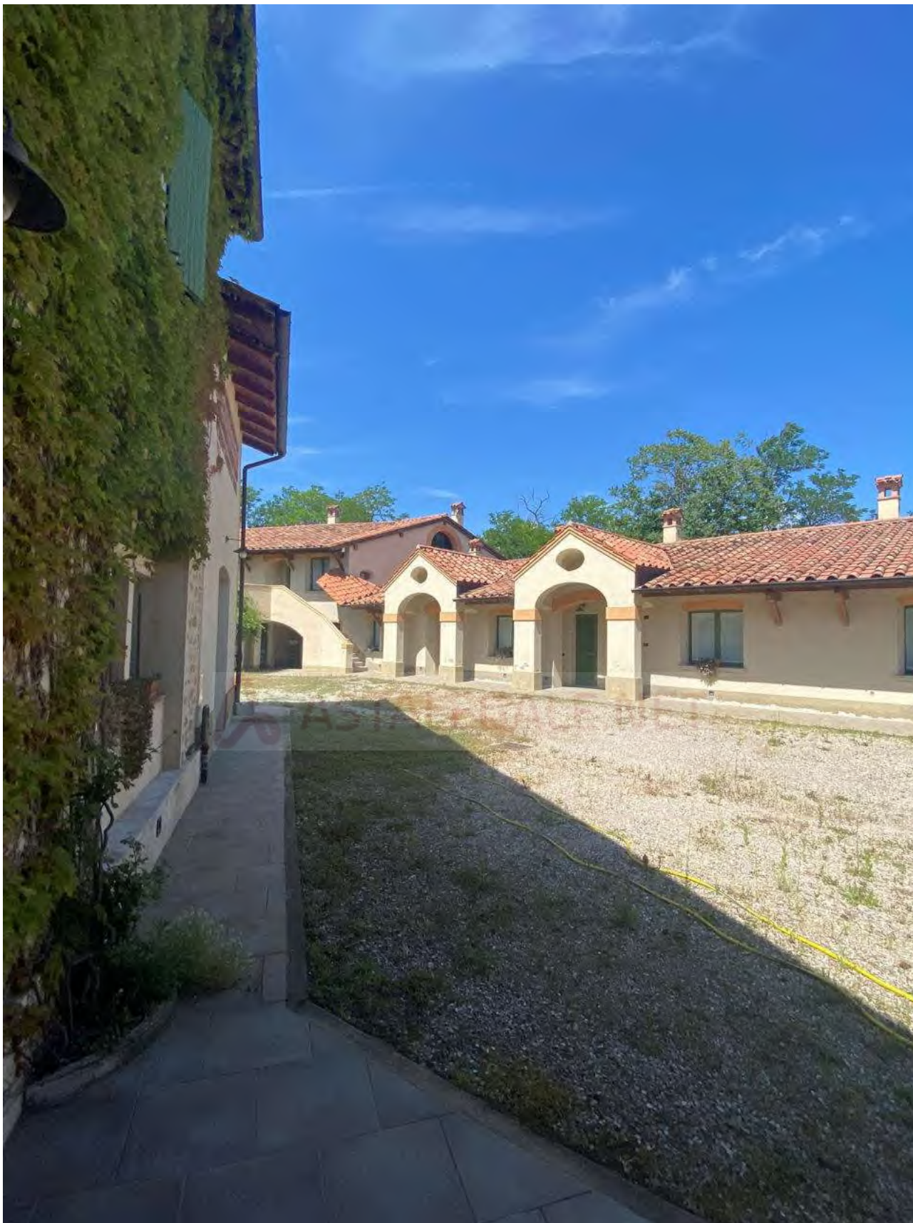
Fot. 04 - Vista interna del complesso agriturismo. Sul lato sinistro la parte posteriore del ristorante.
