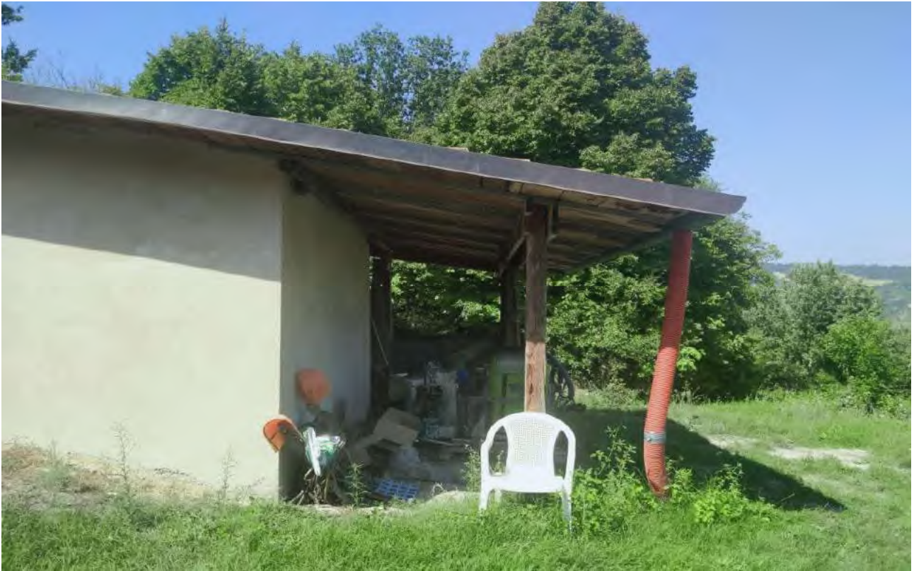
Fot. 2 - Vista della tettoia del proservizio.
