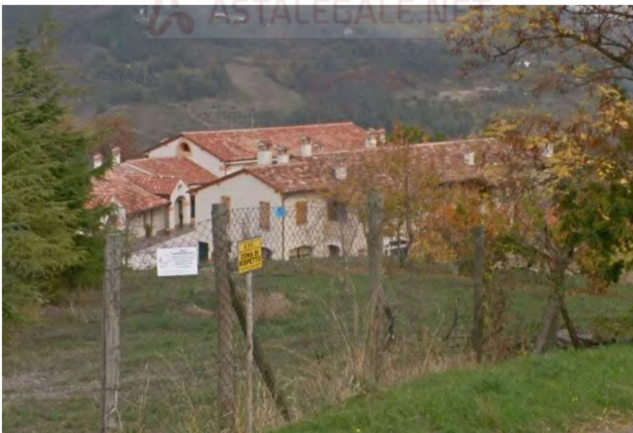
Fot. 02 – Vista ravvicinata del complesso agrituristico da Via dei Frati.
