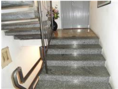
scala per piano interrato
