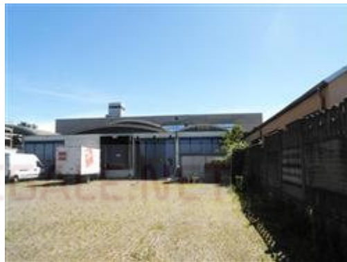
cortile di carico, scarico e manovra
