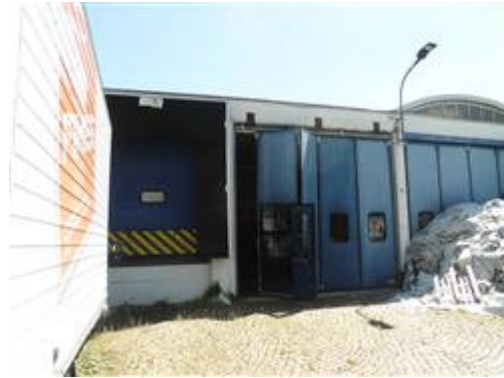
tettoia a portoni scorrevoli
