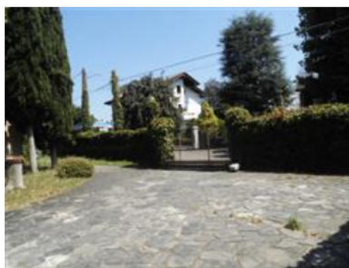
zona ingresso carraio al n. 2 di Via Gramsci e area di manovra
