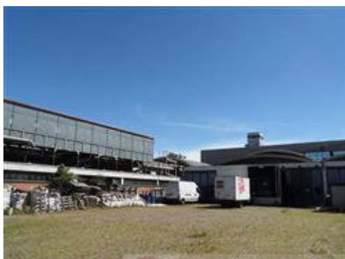
cortile di manovra, carico e scarico materiale
