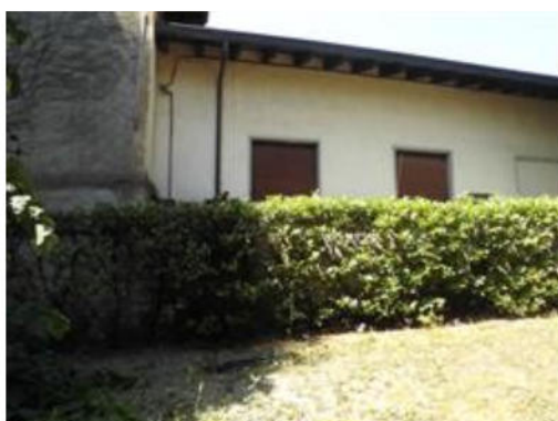
fabbricato lato est
