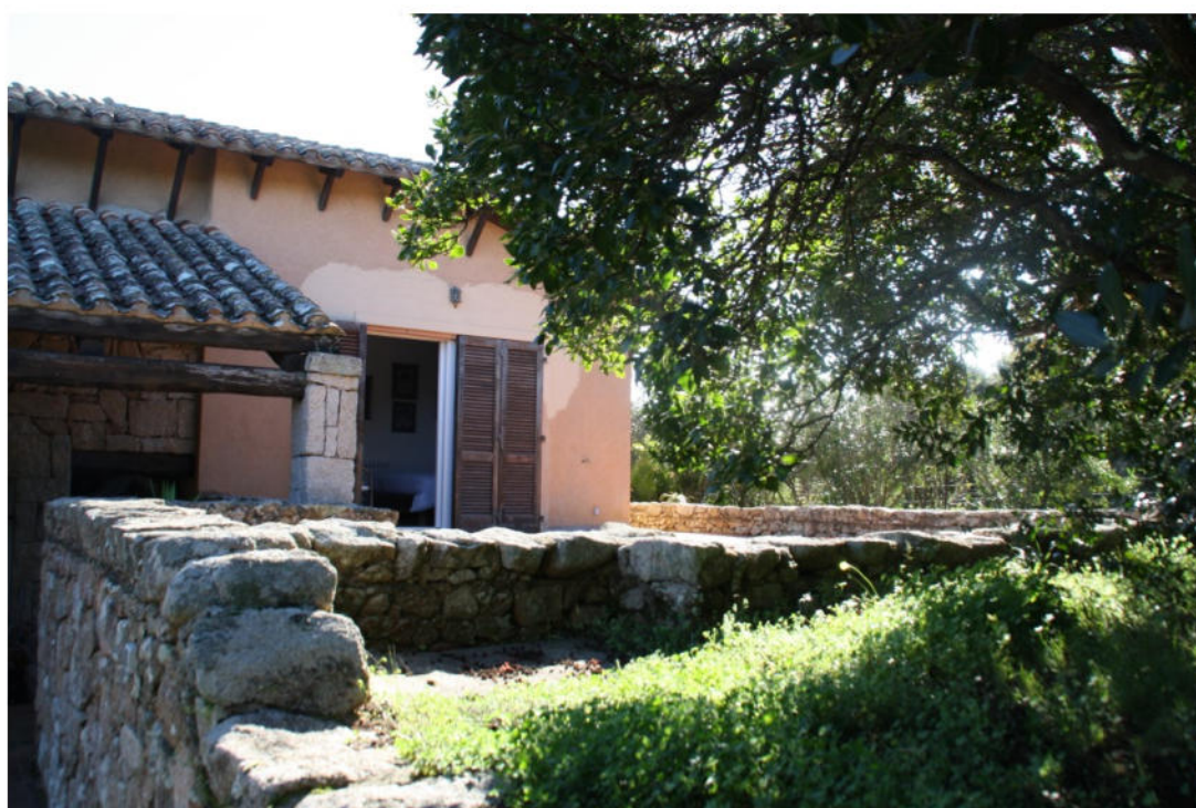
Foto 04 Ingresso alla Villa
