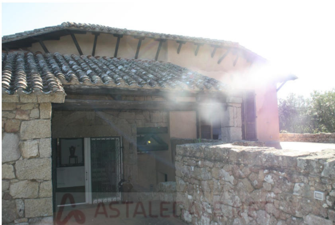
Foto 03 Ingresso alla Villa
