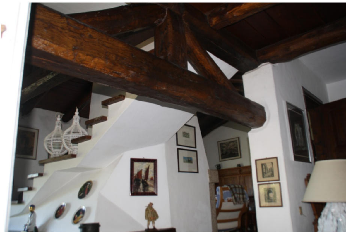
Foto 25 Particolare capriata tetto
