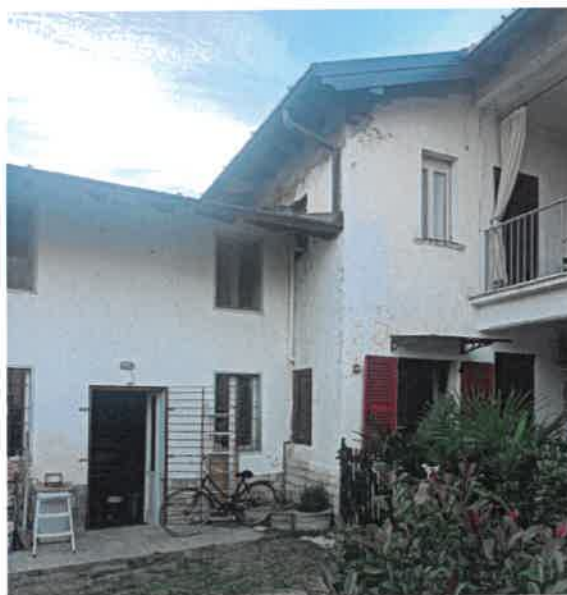
Prospetto ovest con i corpi ripostiglio
