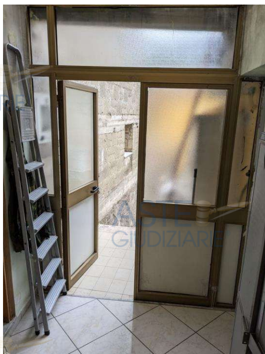
Foto 28: Vista del ballatoio, in parte chiuso con infisso verandato, a protezione dell'ingresso al primo piano, dagli agenti atmosferici.
