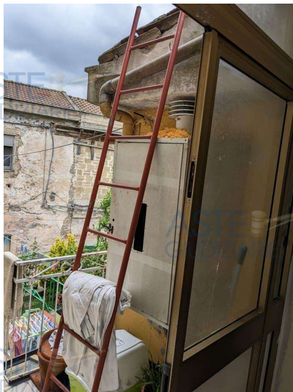
Foto 29: Dal ballatoio si può accedere provvisoriamente al locale sottotetto tramite scala metallica.
