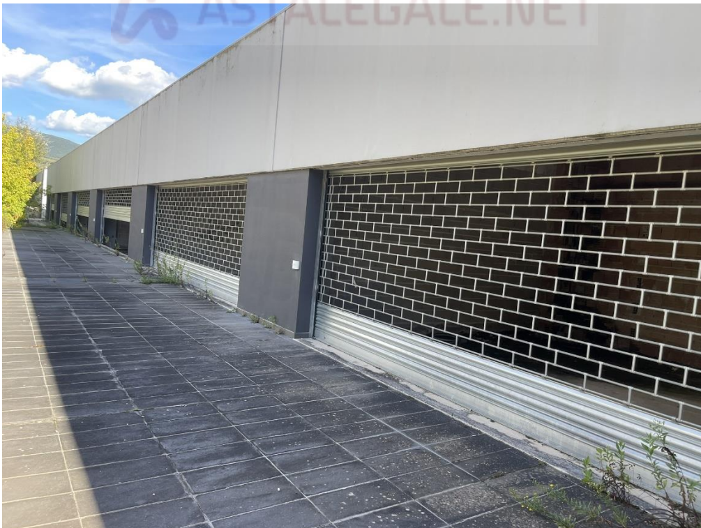
Fotografia n.23 – Piano Primo – Visuale esterna dei negozi posti al Piano Primo
