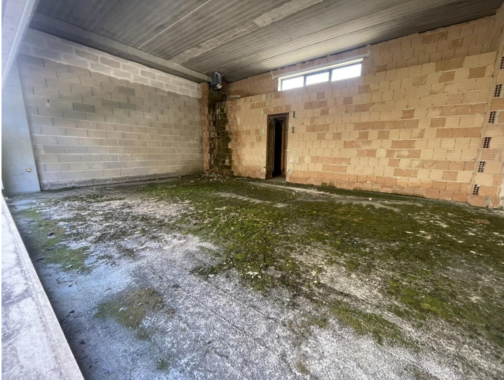
Fotografia n.24 – Piano Primo – Visuale interna dell’Ambiente interno del negozio Tipo.
