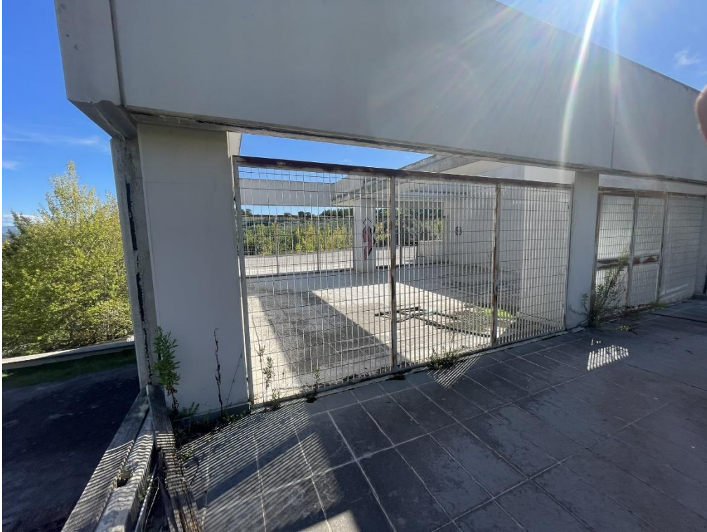
Fotografia n.32 – Piano Primo – Visuale dell’Ambiente destinato alla U.T.A..
