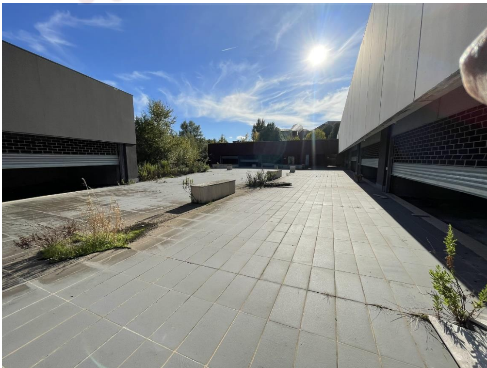
Fotografia n.11 – Piano Terra – Altra visuale del piazzale esterno di collegamento. Sullo sfondo, sulla destra e sulla sinistra dei blocchi destinati a Negozi.
