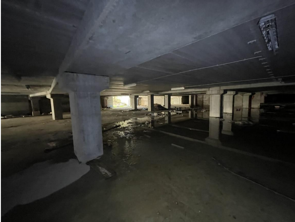
Fotografia n.2 – Piano Seminterrato – L’area destinata a parcheggi.
