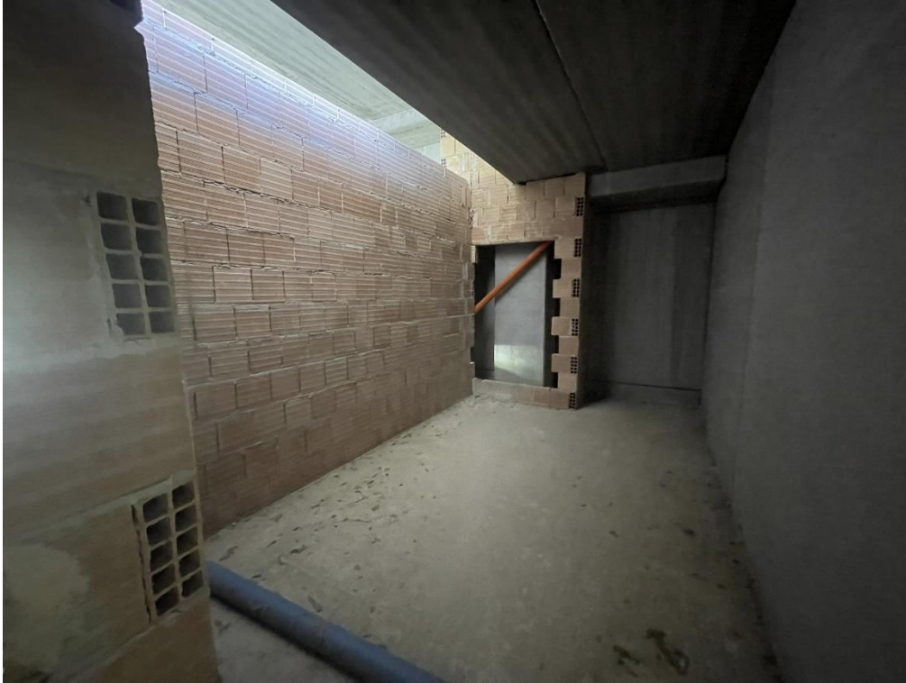
Fotografia n.26 – Piano Primo –Visuale interna dell’Ambiente magazzino del negozio Tipo.
