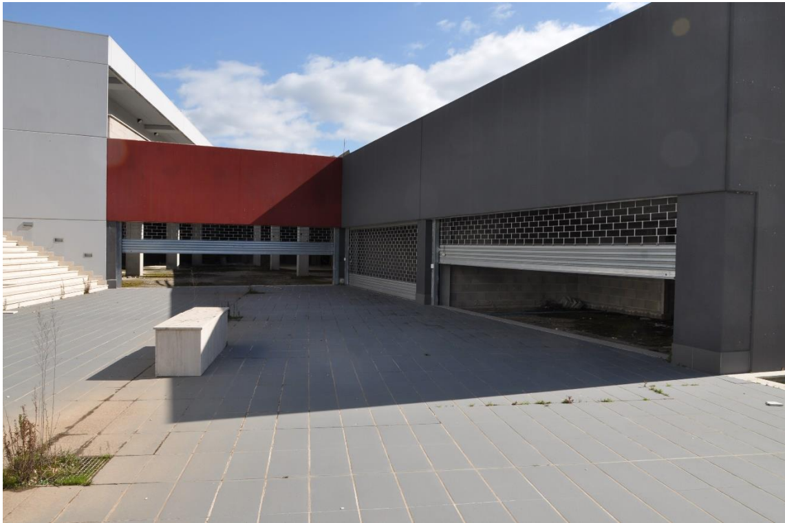
Fotografia n.18 – Piano Terra – Altra visuale esterna delle porzioni immobiliari destinate a negozi ( alla destra del fotogramma) ed a Supermercato ( sullo sfondo del fotogramma).
