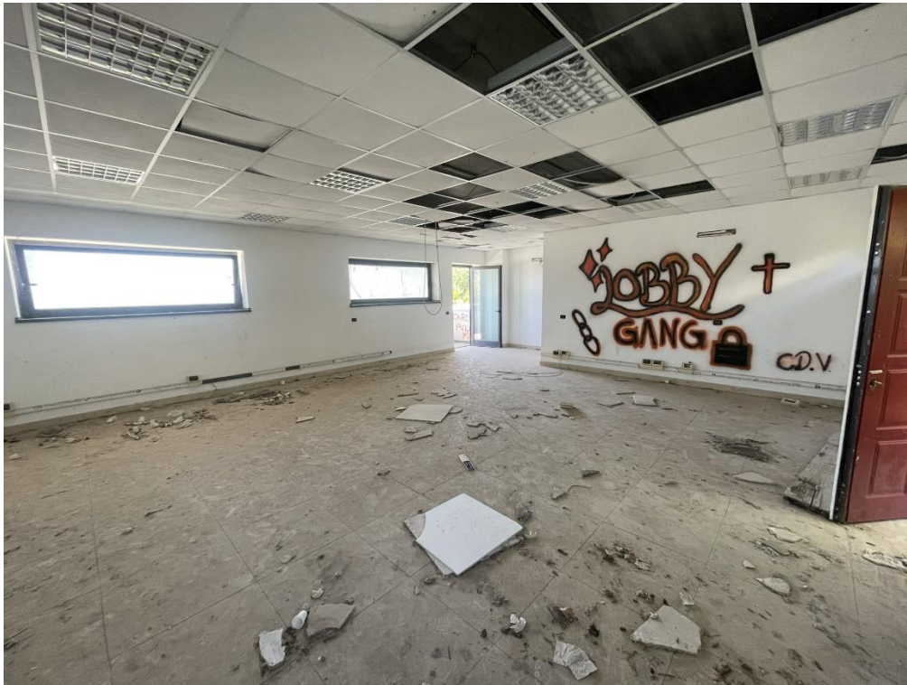
Fotografia n.30 – Piano Primo – Altra visuale interna dell'Ambiente Ufficio Tipo.
