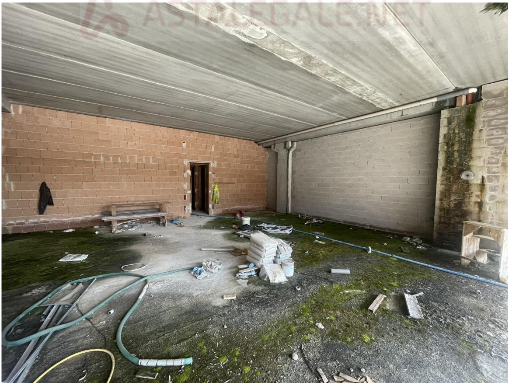
Fotografia n.13 – Piano Terra – Visuale interna dell’Ambiente Negozio Tipo.
