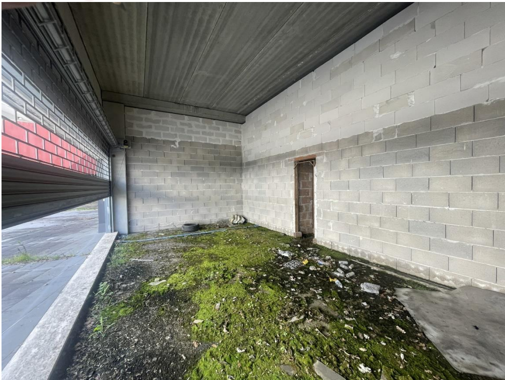
Fotografia n.17 – Piano Terra – Visuale interna dell’Ambiente Negozio Tipo.
