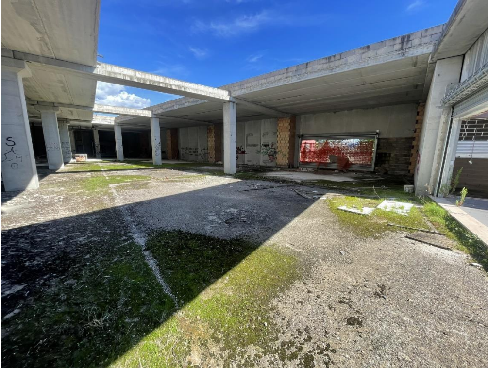
Fotografia n.22 – Piano Terra – Altra visuale degli spazi interni destinati a Supermercato
