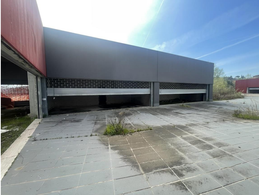
Fotografia n.16 – Piano Terra – Altra visuale esterna dell’Ambiente Negozio Tipo.
