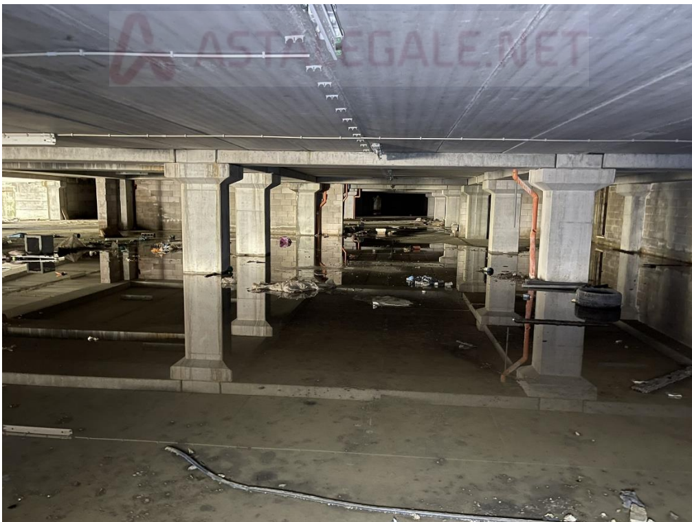
Fotografia n.3 – Piano Seminterrato – L’area destinata a parcheggi.
