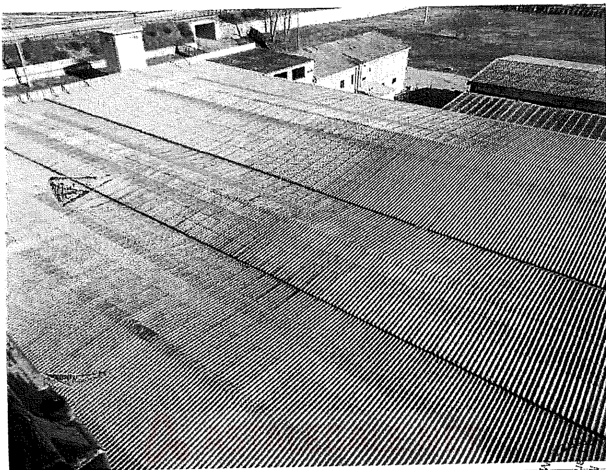
Punto di campionamento n. 02- particolare del discreto stato di conservazione delle lastre.
