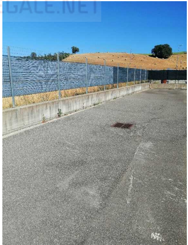
Fotografia 12– Area esterna pertinenziale
