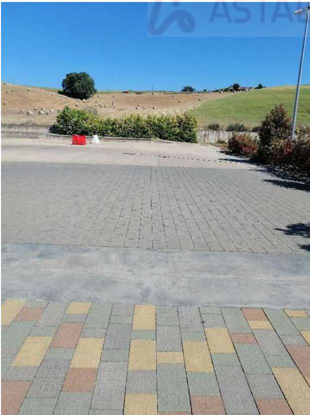
Fotografia 11 – Area esterna pertinenziale
