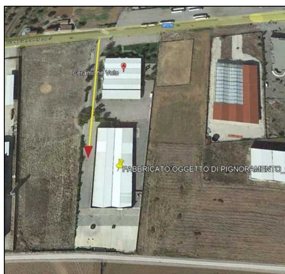
Figura 3 – Accesso al capannone
