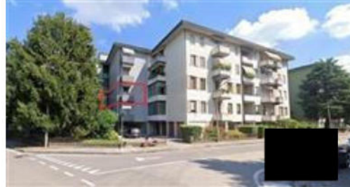
Veduta immobile da Sud
