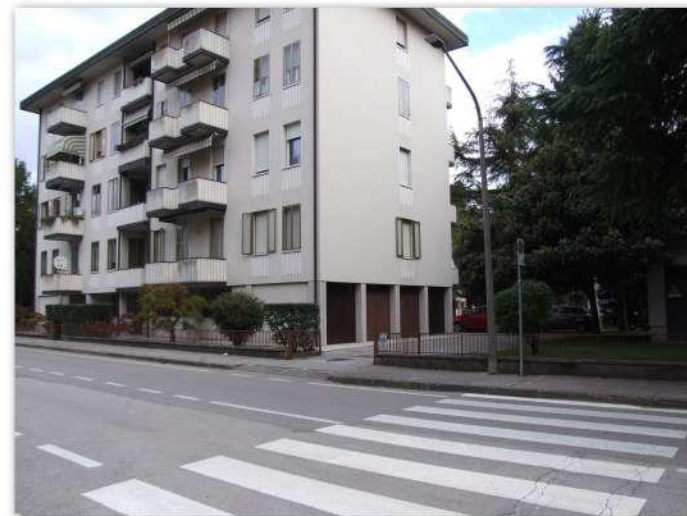
03. Accesso carraio al garage
