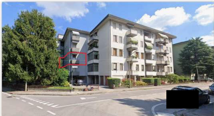
01. Veduta immobile da Sud
