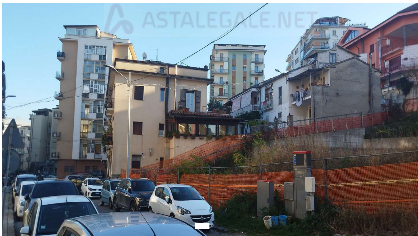
FOTO N°6: VISTA DELLA RECINZIONE DELL'AREA OGGETTO DI ESECUZIONE (OGGI CANTIERE EDILE SUL CONFINE PROSPICENTE VIA DE RADA (SUD-EST));
