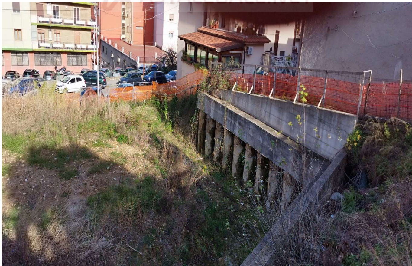
FOTO N°4: VISTA AEREA (DA NORD-OVEST) DELLO SCAVO CHE INTERESSA PREVALENTEMENTE LA P.LLA N° 1475;
