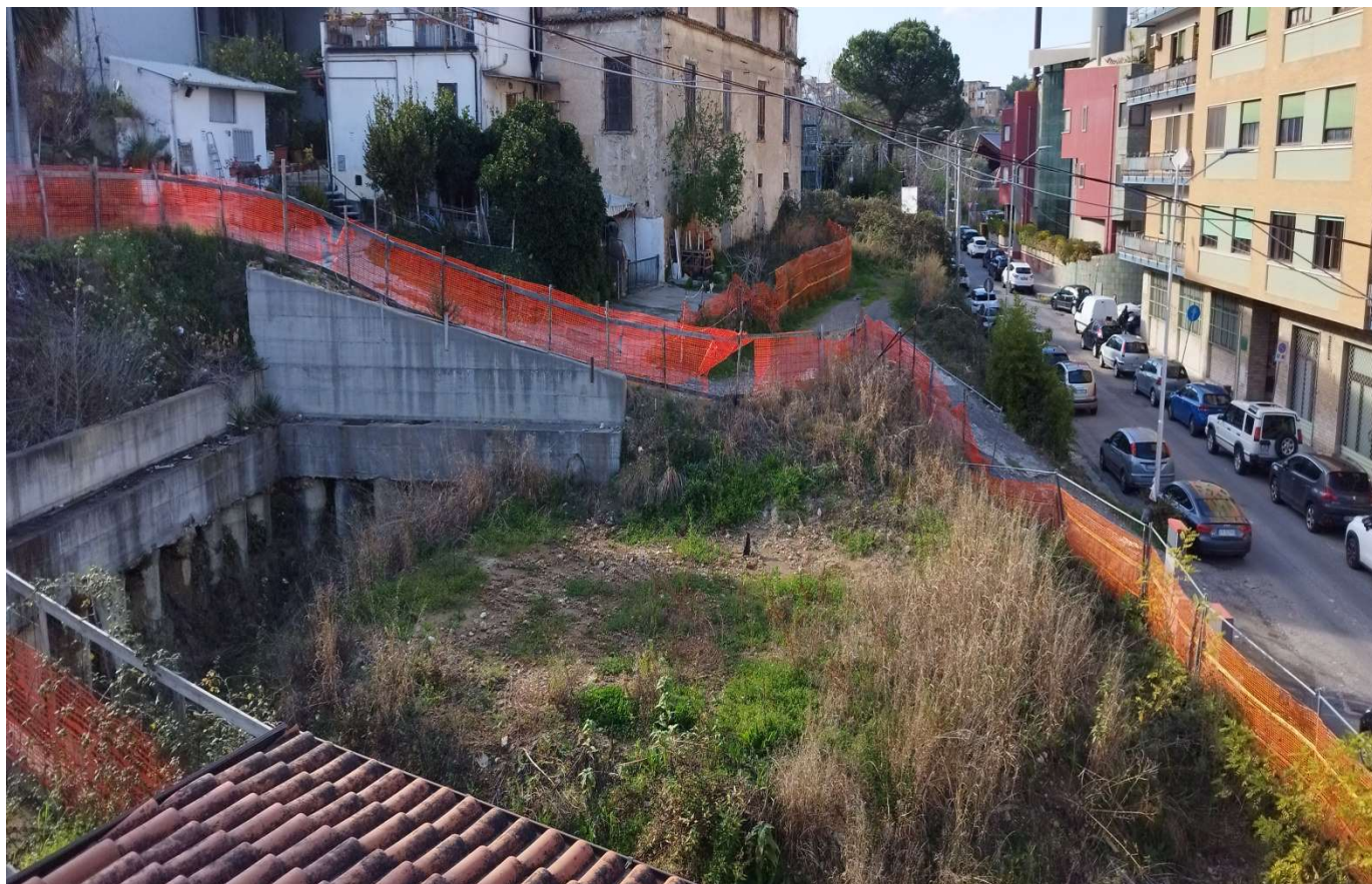
FOTO N°3: VISTA AEREA (DA SUD) DELLO SCAVO CHE INTERESSA PREVALENTEMENTE LA P.LLA N° 1475
