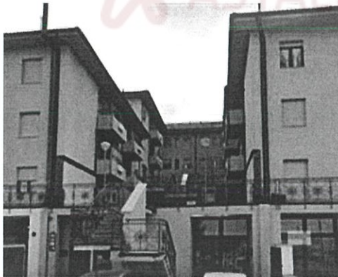
complesso edilizio prospetto nord
