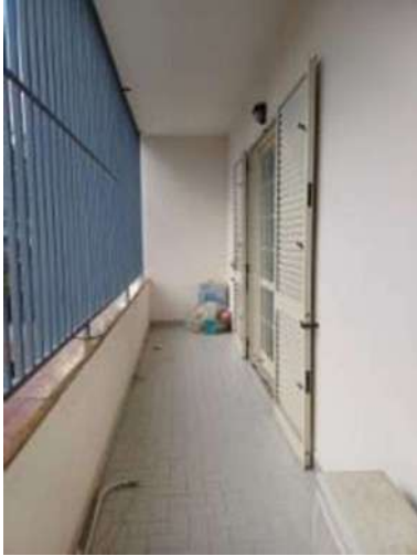
Balcone lato Est
