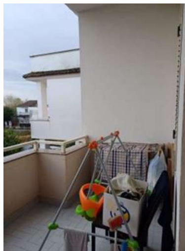
Balcone lato Est
