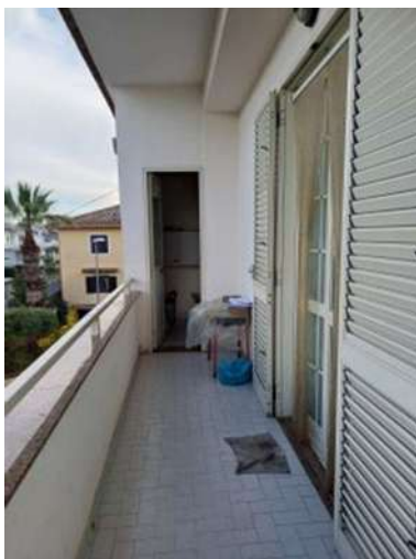
Balcone lato Nord
