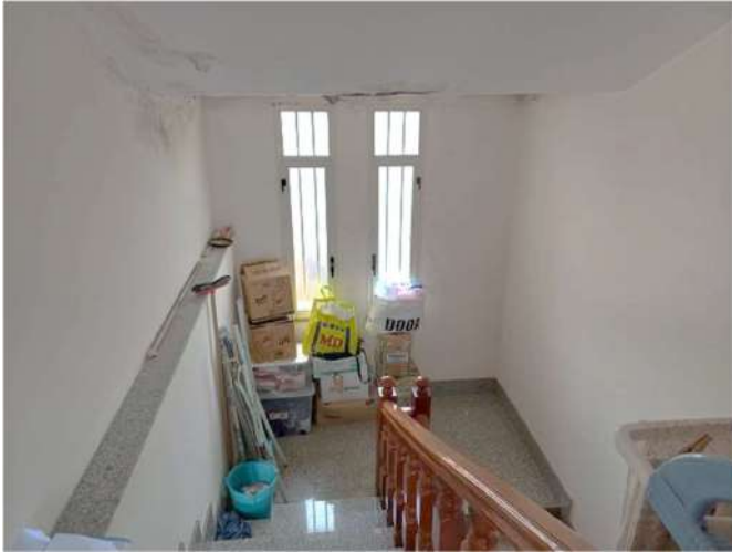
Vano scala interno
