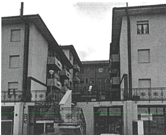
esterno prospetto nord
