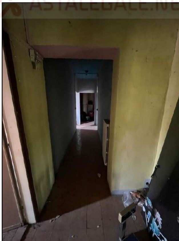
Foto 26: Piano Primo: il corridoio
