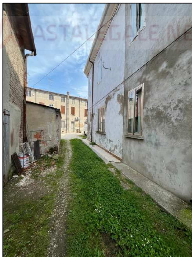
Foto 6: Altra vista del tratto di stradello su cui affaccia il bene pignorato
