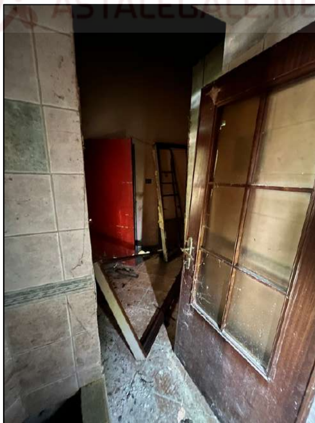
Foto 18: Piano Terra: altra vista della stanza passante
