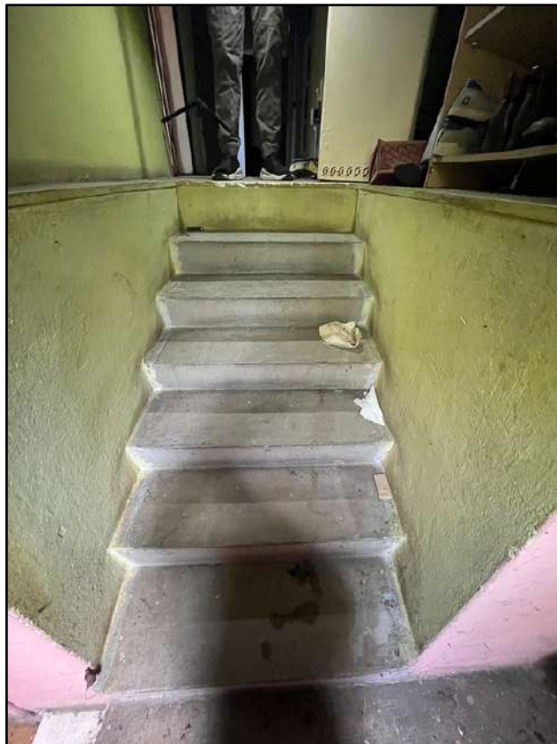
Foto 25: La rampa prima dello sbarco al Piano Primo
