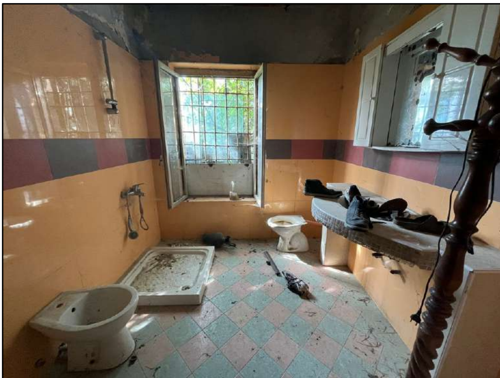
Foto 19: Piano Terra: il bagno
