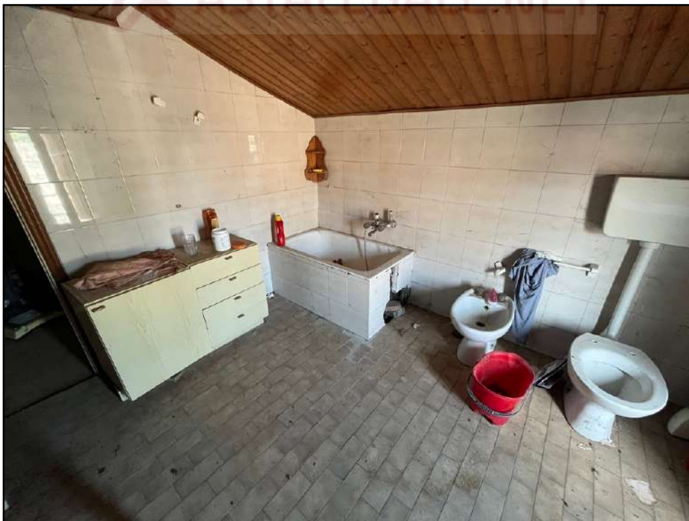
Foto 30: Piano Primo: il bagno – altra vista
