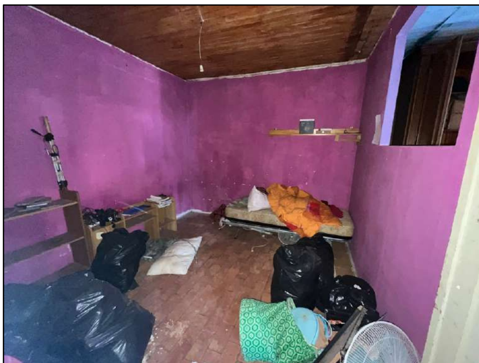
Foto 38: Piano Primo: la stanza ripostiglio – altra vista
