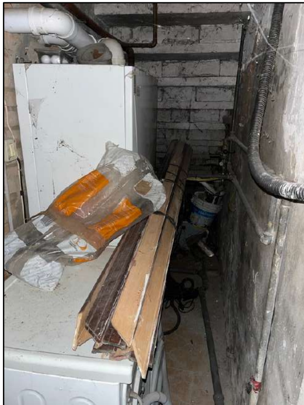
Foto 17: Piano Terra: il sotto scala
