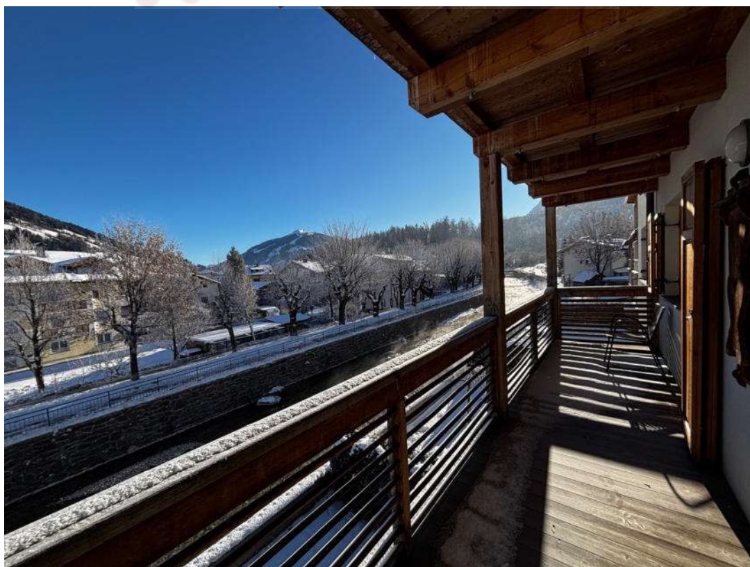
Balcone in direzione Nordovest P.ED. 772 P.M. 5
