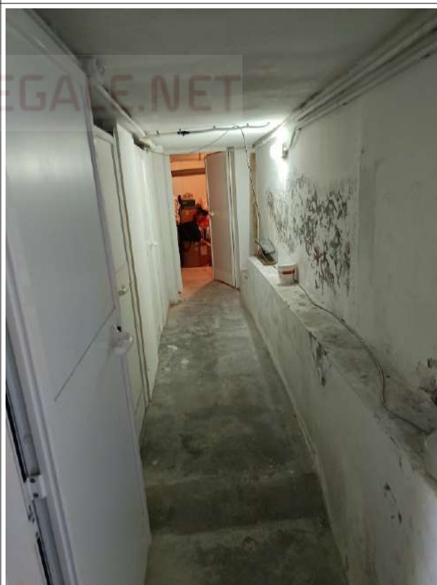
Disimpegno accesso cantina
