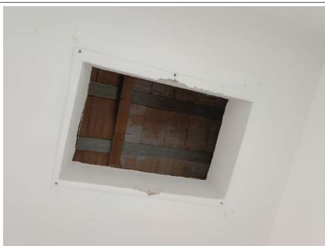
Part botola accesso soffitta da scala condomiale
